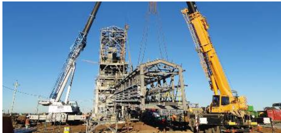
Planta de cemento | Cielo Azul Montaje Año: 2021
