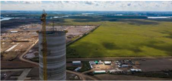
Chimenea | UPM II Montaje Eléctrico Año: 2021
