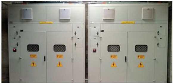
Estación Salto | UTE Montaje de Estación Año: 2017
