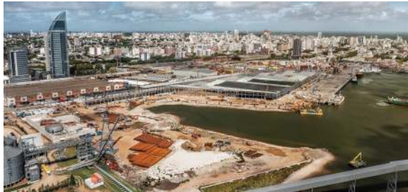
Puerto | UPM II Potencia e Instalación Año: 2022
