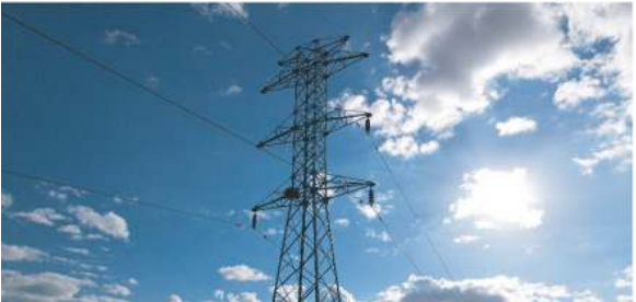
Modificación cruce de línea | UPM II Montaje Eléctrico Año: 2021
