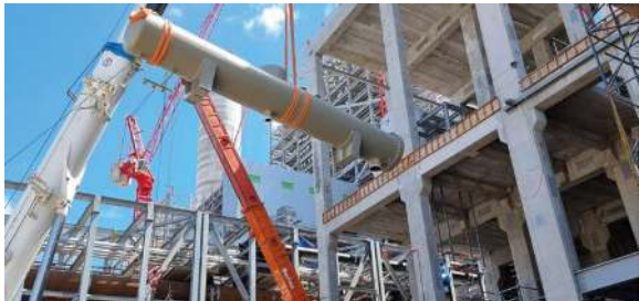
Edificio de turbina | UPM II Montaje y Piping Año: 2023
