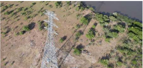
Tendido de línea trifásica | UPM II Montaje Eléctrico Año: 2020
